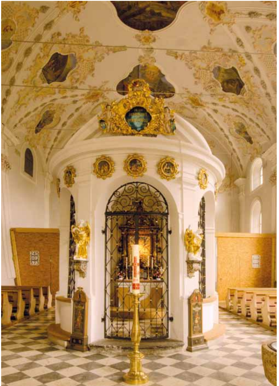
Der vordere Bereich der Kirche wurde durch eine Staubwand abgetrennt.
