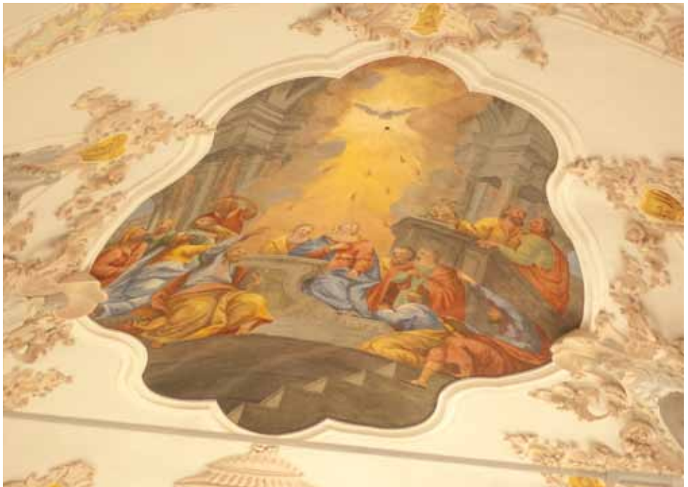
Oben und unten: Deckenfresko nach der Restaurierung. Risse gefüllt und farblich nachgebessert.
